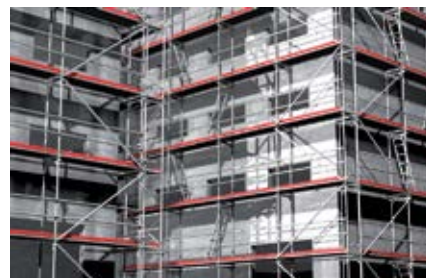
Фасадные строительные леса
